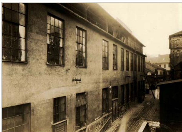
Tovární areál na Cejlu 72 v Brně krátce před znárodněním v roce 1948. Firma tehdy nesla počestný název Mořic Fuhrmann
