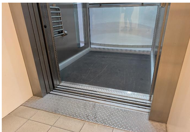
Foto 12: Vstup do výtahu.
