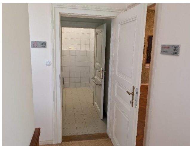
Foto 14: Bezbariérový vstup na WC.
