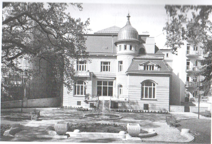
Zahradní průčelí vily Löw-Beer v Brně na Drobného č. 22 po památkové obnově v roce 2015. (foto: Miroslav Zavadil)
