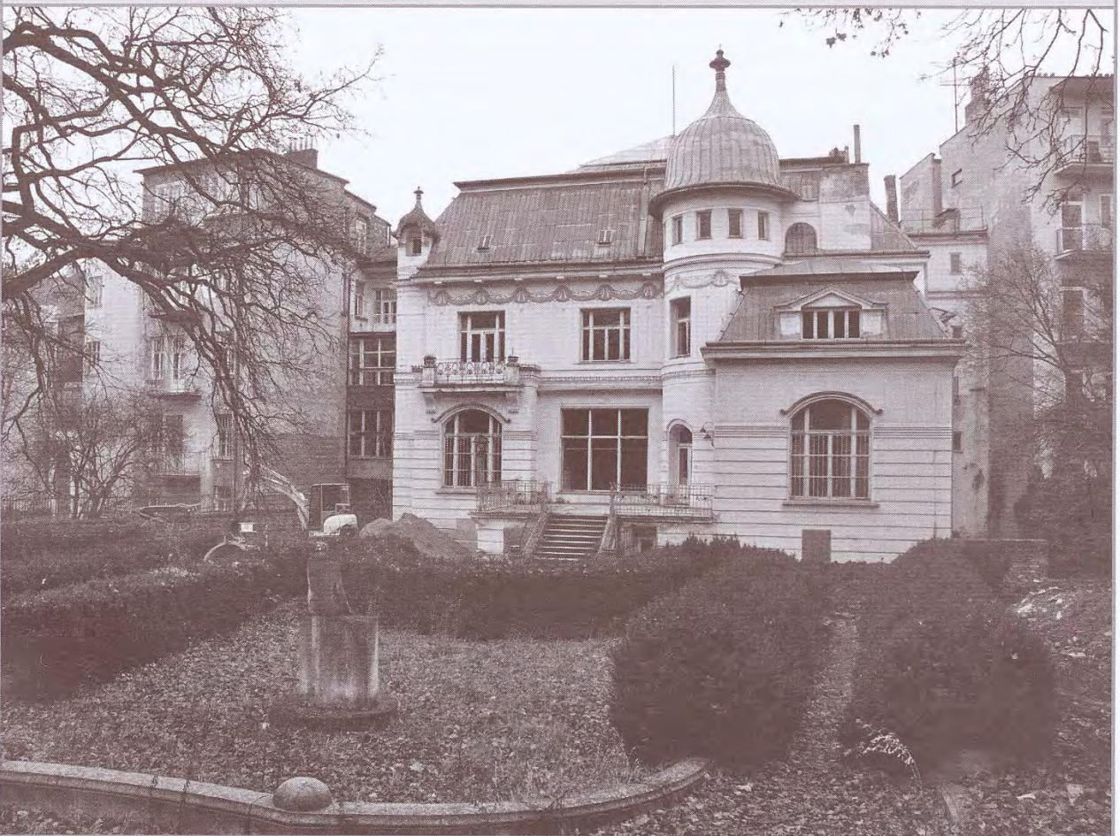
ZÁBĚR ČÁSTI ZAHRADY A ZAHRADNÍHO PRŮČELÍ POŘÍZENÝ V PRŮBĚHU STAVEBNÍCH PRACÍ, V LISTOPADU 2013 (FOTO PETR MRKVIČKA)
